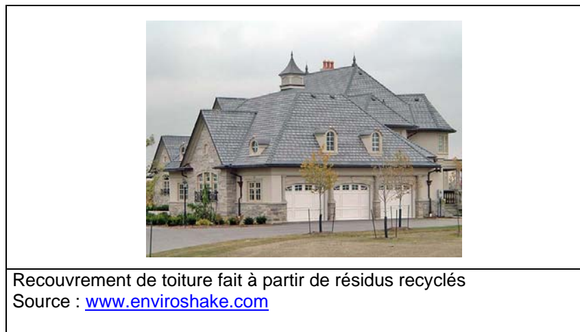
Photo 12 : Recouvrement de toiture avec un matériau écologique
