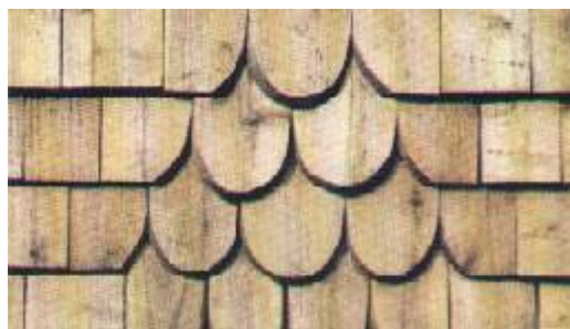
Photo 7 : Parement extérieur, y compris des coupes spécialisées
