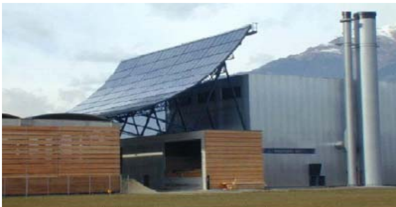
Centrale de cogénération à la biomasse forestière de Lienz (Autriche) Source : Bios Bioenergiesysteme GmbH
